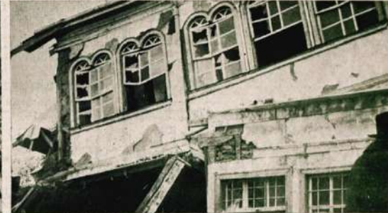
Şiddetli sarsıntılar neticesinde bir kısmı yıkılan ve çöken bir evin manzarası
