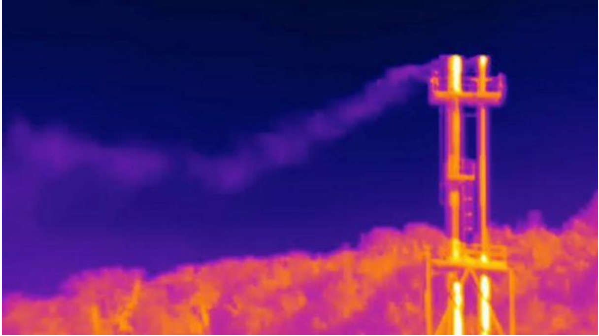
Doğal gaz işletme tesisinden sızan metan gazını gösteren kızılötesi kamera görüntüsü
